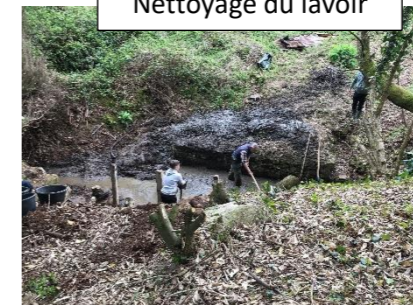
Nettoyage du lavoir
